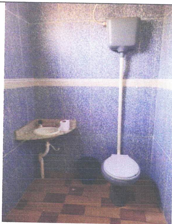
Figura 12: Banheiro. Fonte: Joás Gomes
